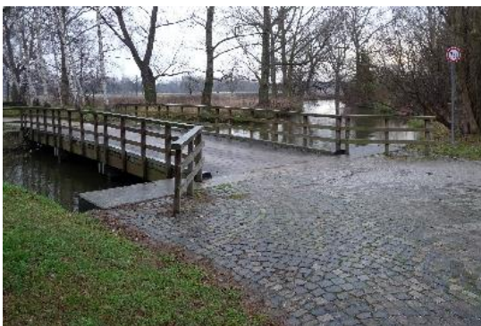
Fußgängerbrücke über die Weiße Elster
